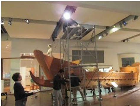
照明器具の交換作業
