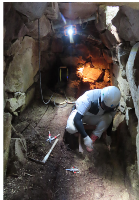
石室内作業状況
